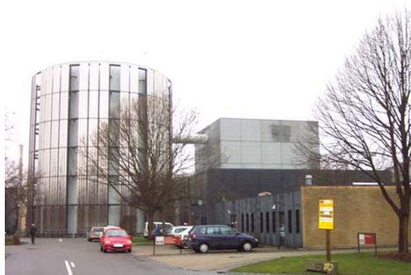
På denne kraftvarmecentral i Lundtofte produceres mere end 90 % af Holte Fjernvarmes varmesalg
